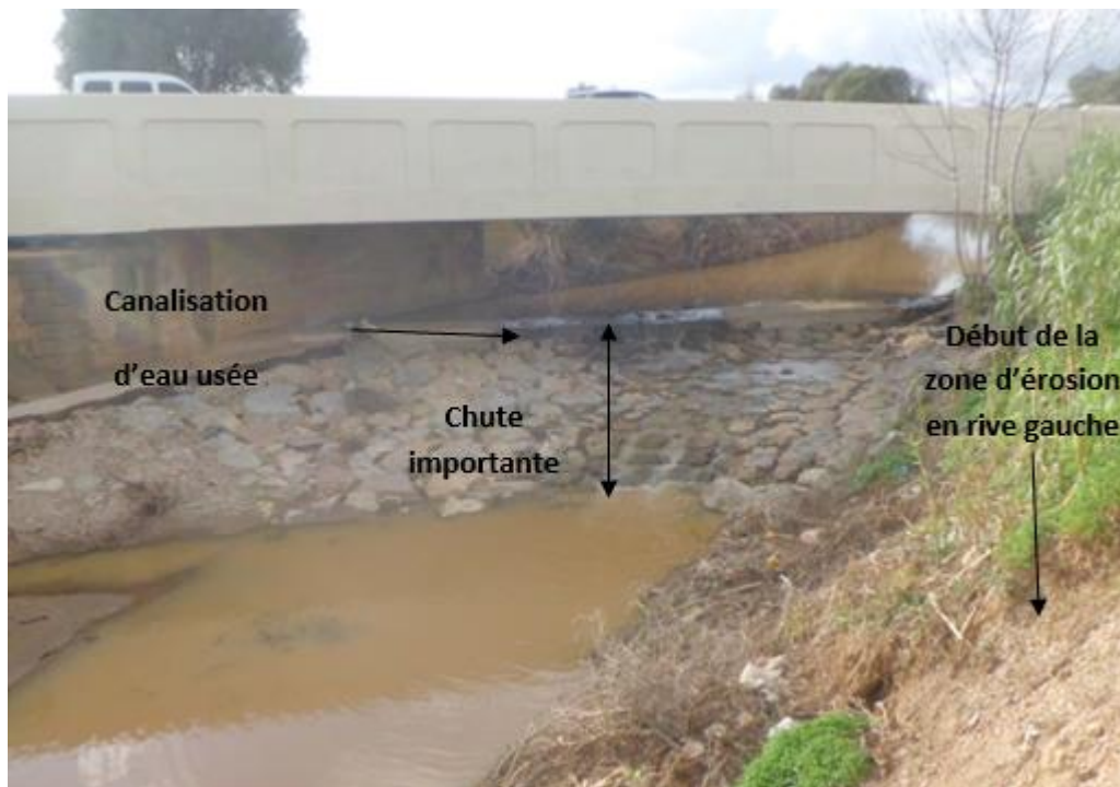
Figure 6-5 Pont Blanc vu de l'aval
