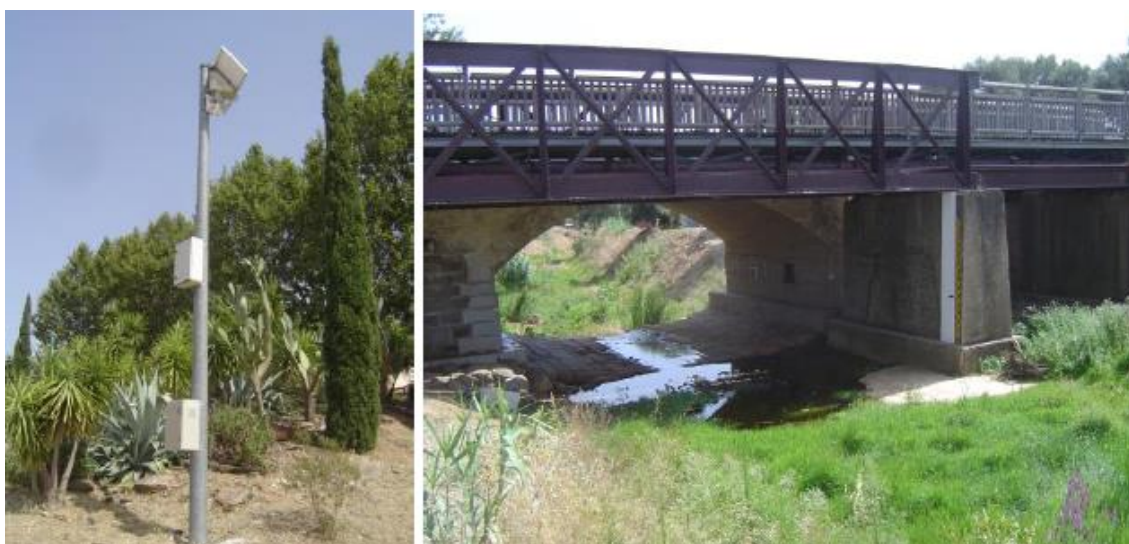
Figure 9-1: Mise en place récente d'une caméra de surveillance des niveaux d'eau au droit du pont de la cave coopérative
